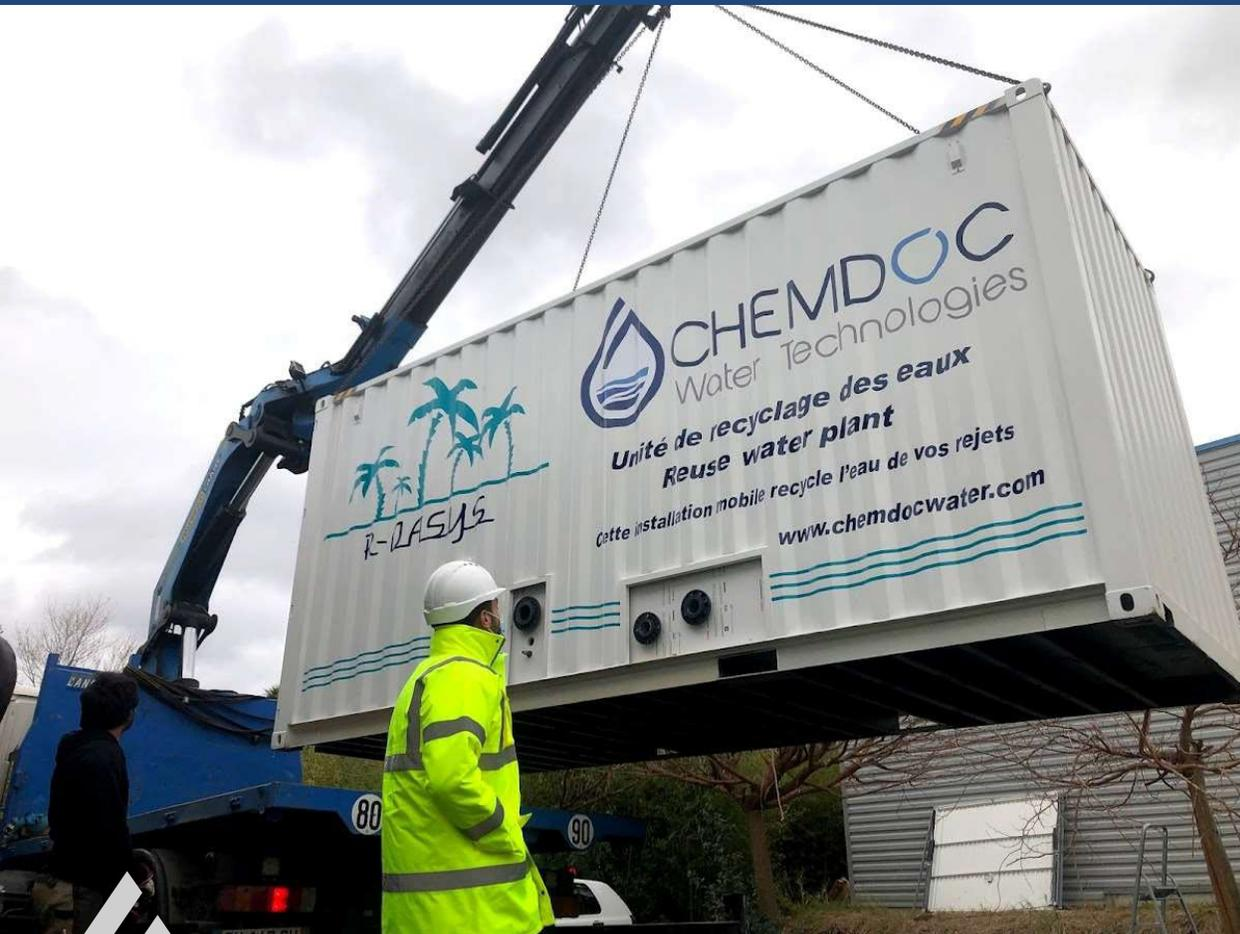
Unité ReUSE eaux pluviales pour refroidissement TAR >10MW
